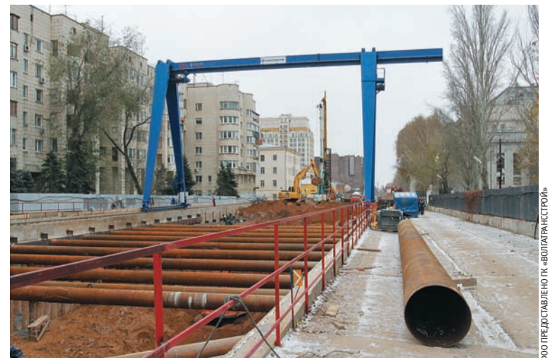
Строительство станции метро «Театральная»
